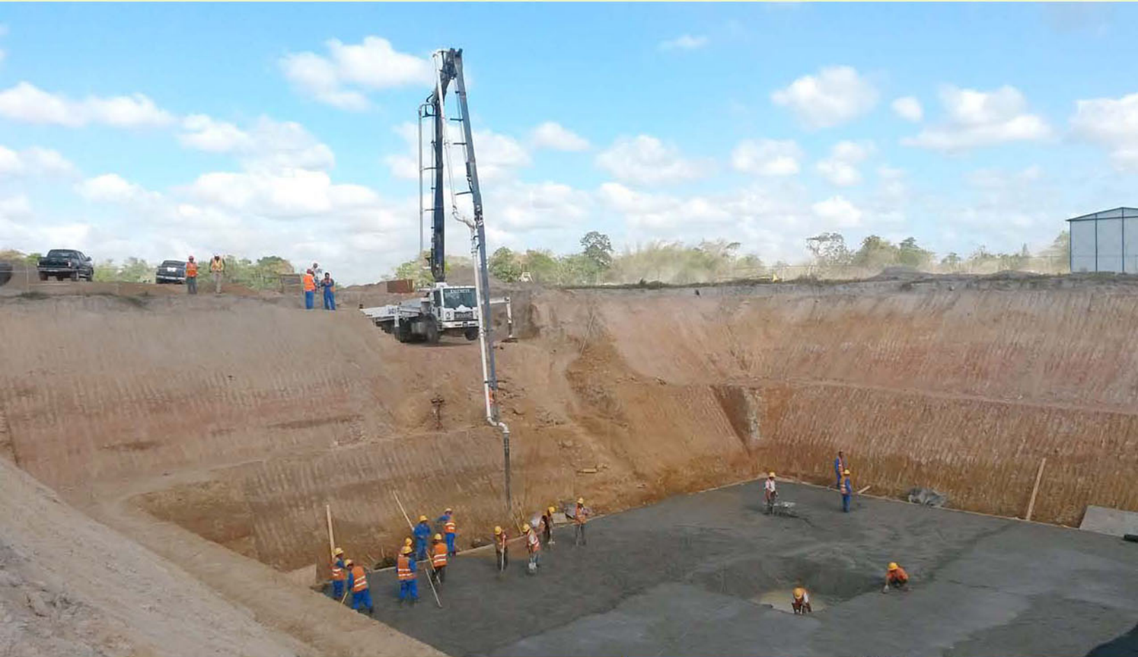
CONCRETE POUR AT SITE FOR NEW MALABAR WWTP - 2015
